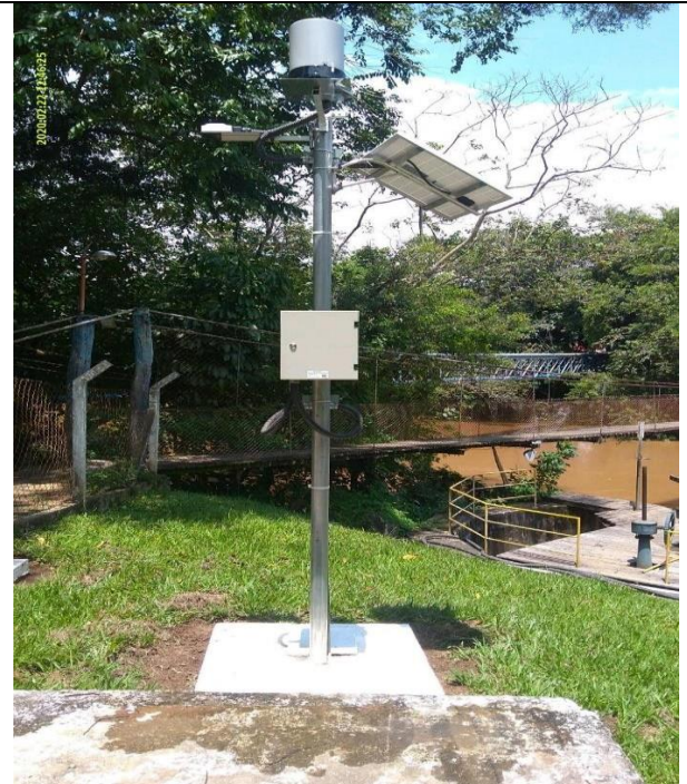
Foto 21 - Estação Telemétrica Limpa (perto)
