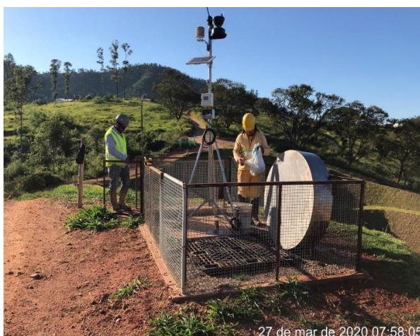
Foto 3 – Detalhe da manutenção da estação. (Data: 27/03/20).
