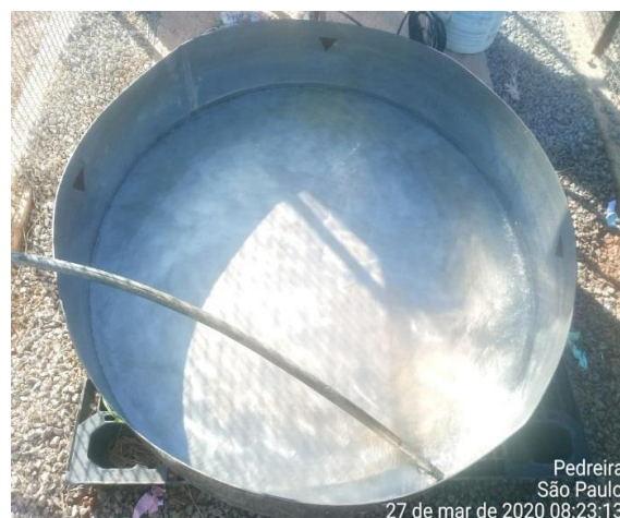
Foto 4 – Limpeza do tanque do reservatório. (Data: 27/03/20).
