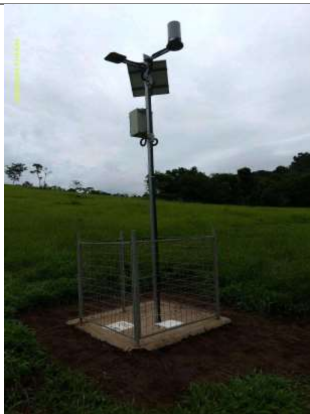
Foto 6 - Estação Telemétrica Limpa (perto)
